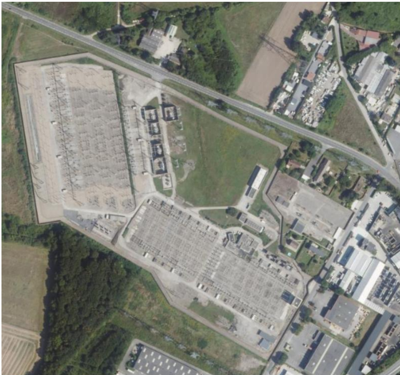
Figure 4 : photo aérienne du transformateur ( source Google Maps)
