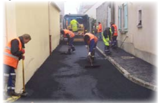
La fin des travaux... très proche
