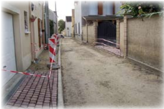
Le début des travaux
